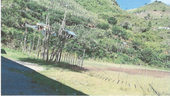
Foto 2: Los postes del muro perimetral no sirven.
